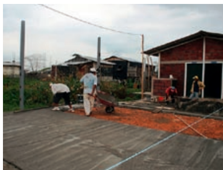
Neuerrichtung eines zerstörten Schulgebäudes
