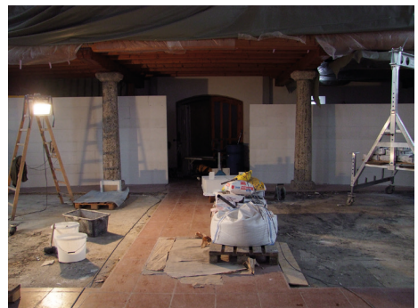
Neugestaltung im Bereich der Empore
