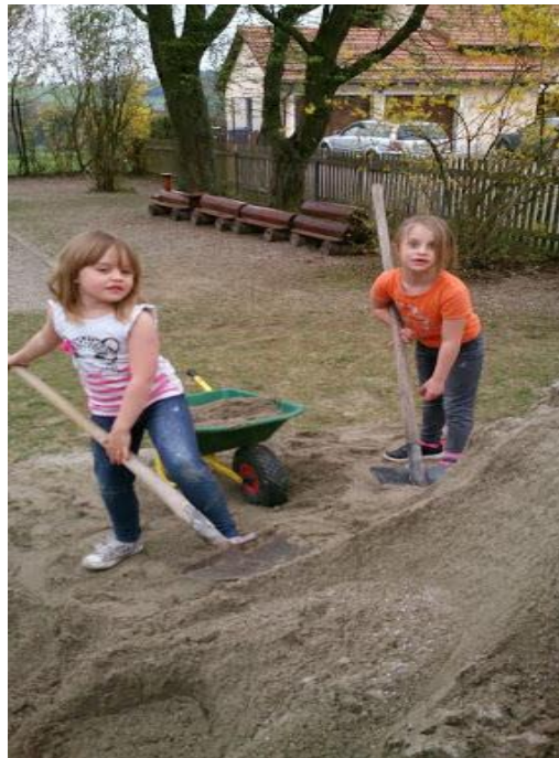
Die Kinder helfen fleißig beim Bau des Matschbereichs
