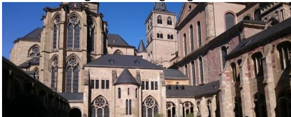
Es ist nicht immer einfach, Kirchengebäude zu beheizen; Dom zu Trier. Foto: Hermann Hofstetter
