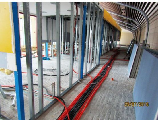
Reparaturarbeiten im Garderobenbereich
