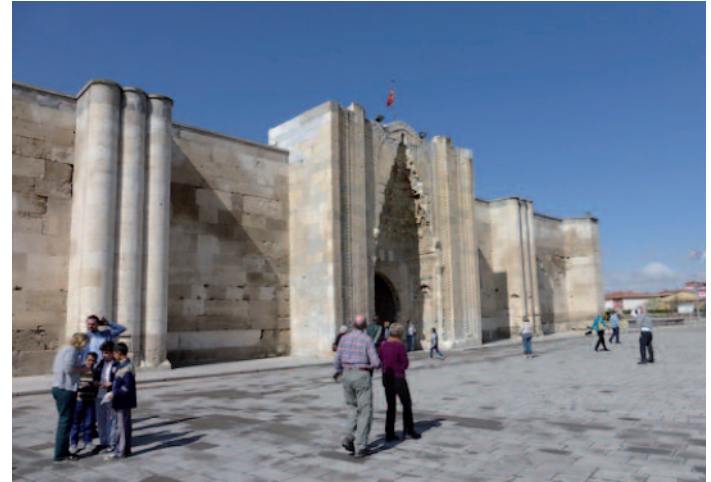
Außenansicht der Karawanserei von Sultanhani (Türkei)
