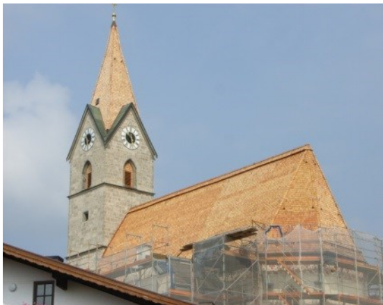
Ein gutes Beispiel für nachhaltiges Restaurieren: Einheimische Holzschindeln wurden bei der Dacherneuerung der Pfarrkirche Seebruck verwendet. Foto: Karl Hartl
