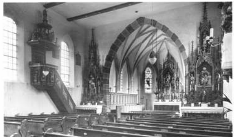
Marienkirche Alling. Innenansicht
