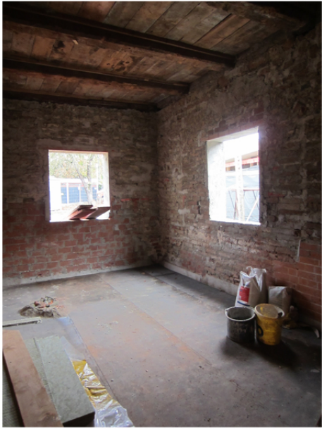
Ansicht Mauerwerk Innen
