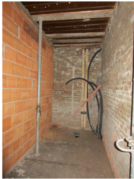
Ansicht Mauerwerk Innen
