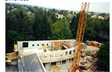
Der Rohbau mit dem noch kleinen Küchenfenster
