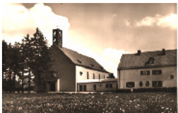
Christi Himmelfahrt, eingeweiht 1933. Der kleine Mittelbau wurde 1954 erstellt
