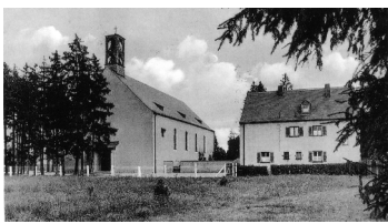
Vor der Kirche war eine große Kiesgrube, die 1949 zugeschüttet wurde
