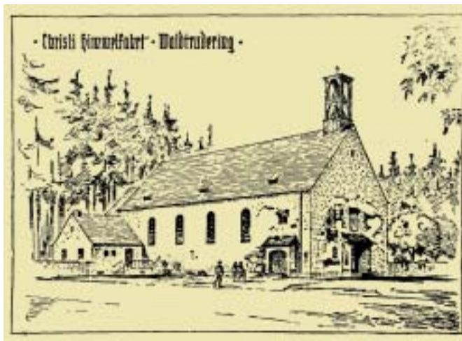
Postkarten als Bausteine für die neue Kirche in Waldtrudering
