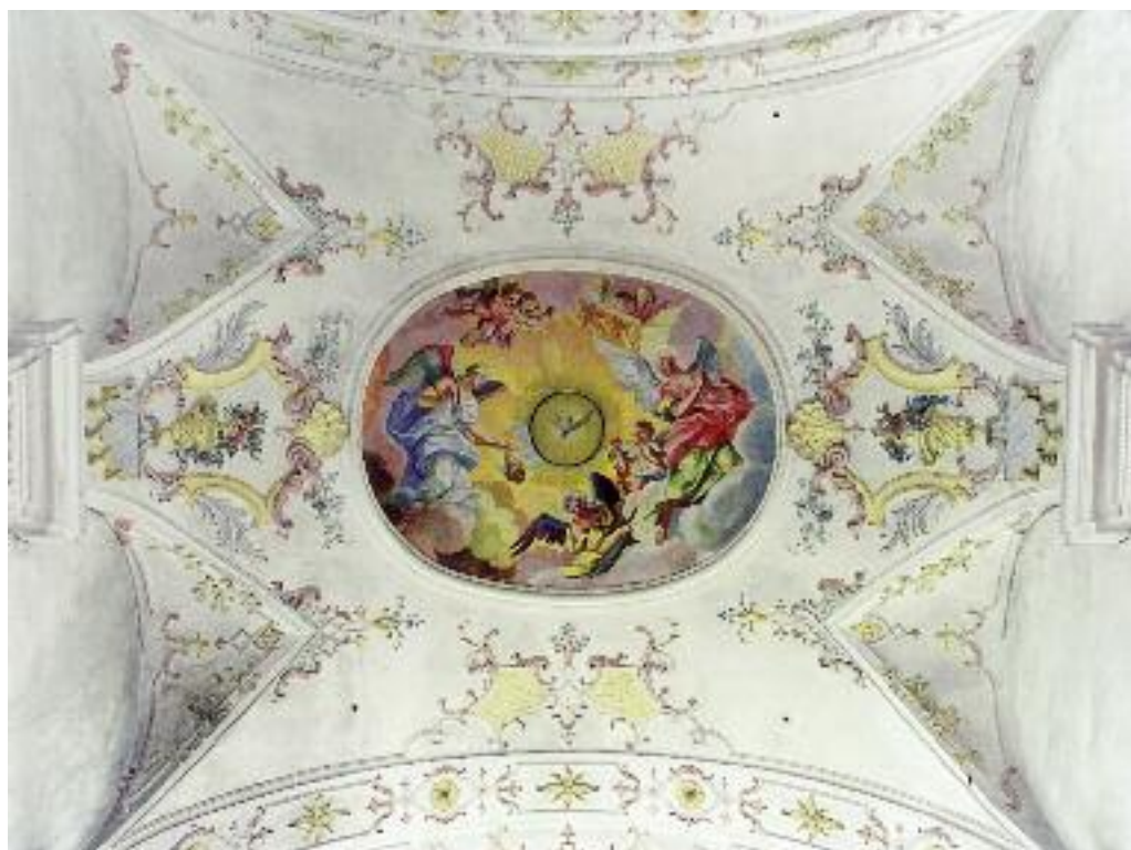
CHORGEWÖLBE DETAIL, VORZUSTAND
