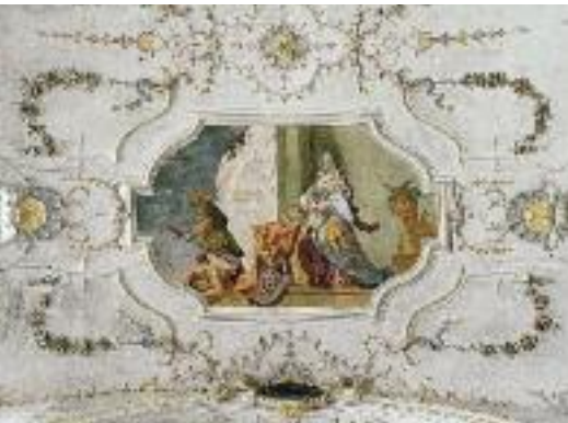
LANGHAUSGEWÖLBE DETAIL. VORZUSTAND
