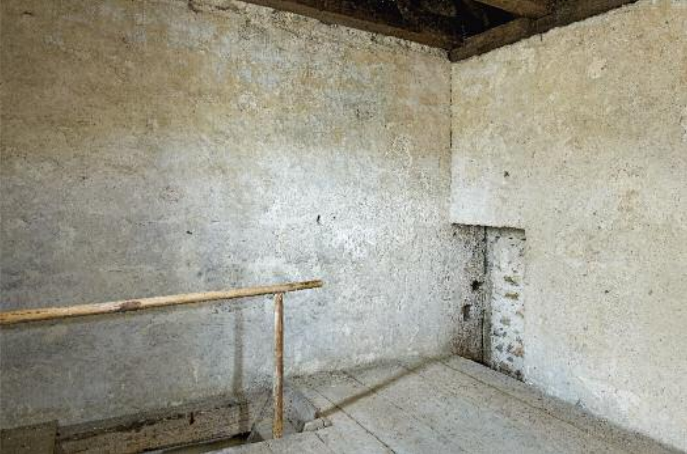
EHEMALIGER EINGANG ZUM OBERGESCHOSS
