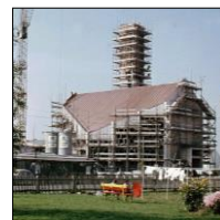
Pfarrkirche im Bau
