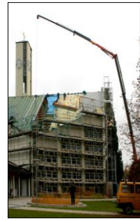
Erneuerung des Kirchendachs
